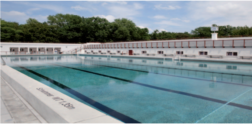
Das neue/alte Hochschulbad: Seit 2012 wieder eröffnet
